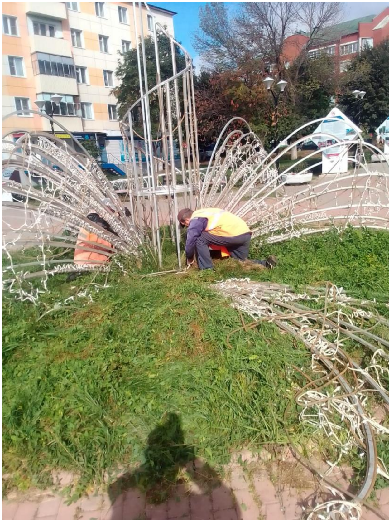
Демонтаж конструкции клуб Ухтомского
