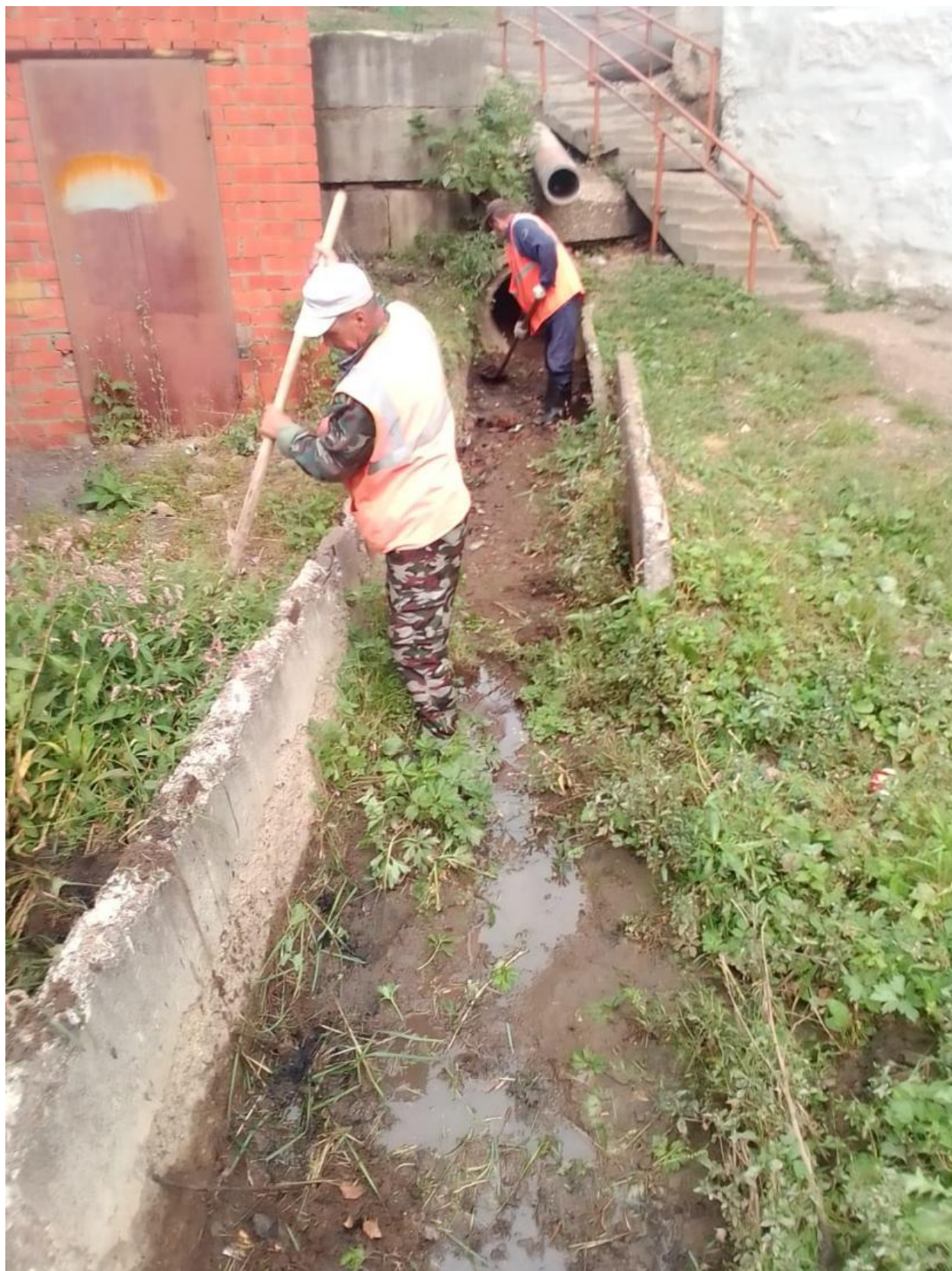
Очистка водопропускного лотка ул.Ставского
